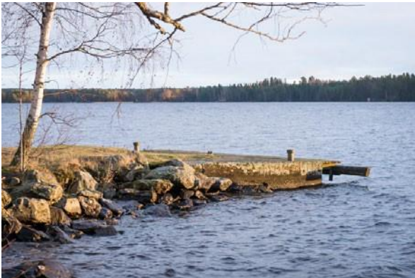
Kuva 41. Betonilaituri kaava-alueen lounaiskulmassa. (Kuva: Pasi Vierimaa, 12/2015.)
